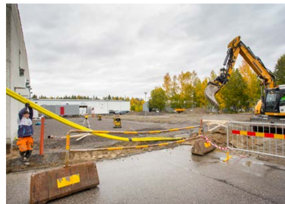
La construction de nouvelles zones de production et de bureaux est en plein essor.
