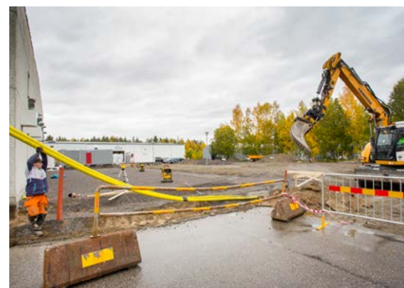
Die Konstruktion neuer Produktionsbereiche und Büros ist in vollem Gange.
